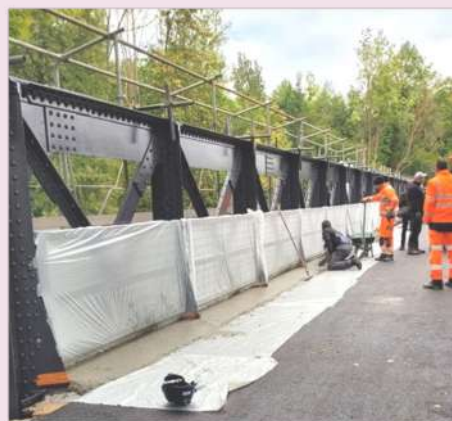
Seconde couche d'enrobé, réalisation des bordures en béton, démontage des échafaudages.
