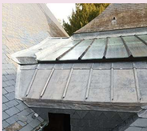
Poursuite des travaux à l'église Sainte Cécile. Pose d'une verrière au dessus de la sacristie
