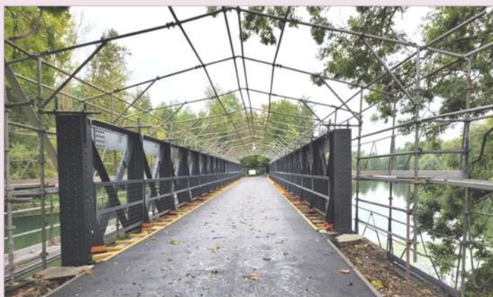
Seconde couche d'enrobé, réalisation des bordures en béton, démontage des échafaudages.
